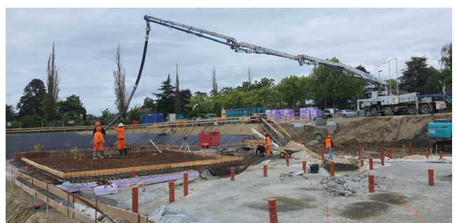
Bétonnage du socle de grue
