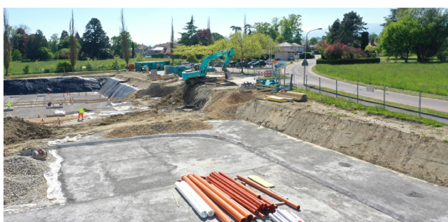
Vue aérienne des terrassements
